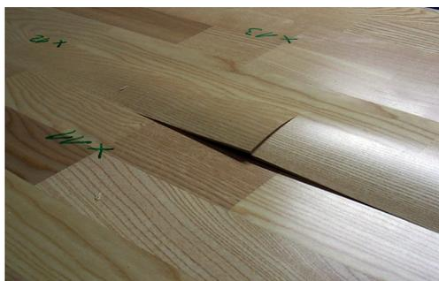
Schichtweise Delaminierung eines Fußbodenaufbaus durch Klimaeinfluss
